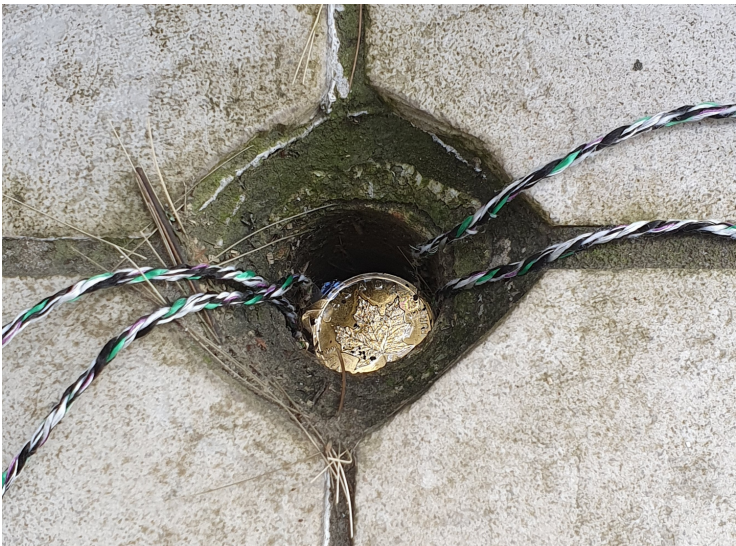
Abbildung 1: Auch der Abfluss des Balkons kann als Versteck genutzt werden.
